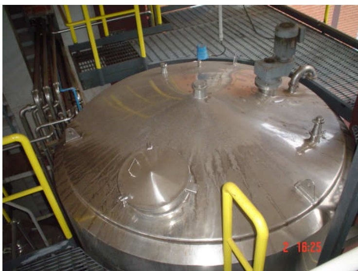
Figura 3.1: Detalhe da cúpula de um tanque de armazenamento.
